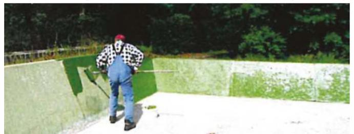
Mit der hochflorigen Rolle (ca. 18 mm) die Epoxid 2 in 1 Beschichtung AC 122 auf die trockene Silowand aufrollen (Verbrauch: mind. 400 g/m<sup>2</sup> je nach Untergrund, Verarbeitungszeit: ca. 20 Minuten). Die Beschichtung AC 122 besitzt ein sehr gutes Haftungs- und Eindringungsvermögen und zeichnet sich durch hohe Abriebfestigkeit und Chemikalienbeständigkeit auf. Bodenbeschichtungen vermeiden. Rauhe und saugende Oberflächen mit AC 115 Flex grundieren.
