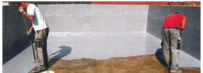
Mit der hochflorigen Rolle (ca. 18 mm) die Epoxiddeckversiegelung AC 130 auf die trockene Grundierung AC 110 aufrollen (Verbrauch: mind. 300 g/m<sup>2</sup> je nach Untergrund, Verarbeitungszeit: ca. 20 Minuten). Die Deckversiegelung AC 130 ist aufgelegt auf hohe chemische und mechanische Belastbarkeit. Bis zum Beschicken der Fläche sollte ca. 48 Stunden gewartet werden (abhängig von Temperatur und Luftfeuchtigkeit).
