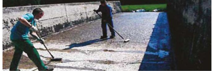
Mit einer hochflorigen Rolle (ca. 18 mm) die Epoxidgrundierung AC 110 auf die trockene Fläche der Betonbodenplatten und Silowände aufrollen (Verbrauch: mind. 300 g/m<sup>2</sup> je nach Untergrund, Verarbeitungszeit: ca. 20 Minuten). Die Grundierung AC 110 legt sich nicht nur auf die Oberfläche, sondern dringt in und verankert sich dort. In der Regel kann nach ca. 24 Stunden mit der Deckversiegelung AC 130 weiter gemacht werden (abhängig von der Temperatur und Luftfeuchtigkeit).
