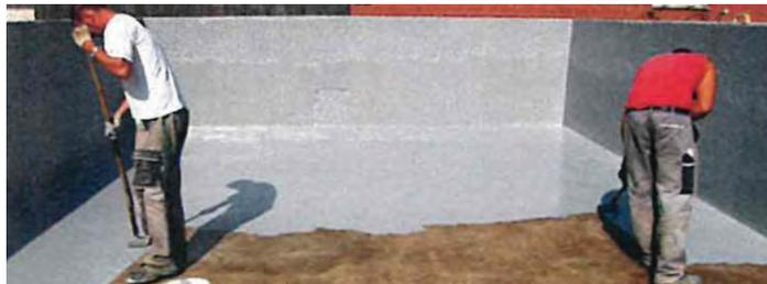
Avec un rouleau à poils longs (env. 18 mm), appliquer le vitrificateur époxy de finition AC 130 sur l'apprêt sec AC 110 (consommation : min. 300 g/m<sup>2</sup> selon le support, temps de traitement : env. 20 minutes). Une fois appliqué, le vitrificateur de finition AC 130 résiste aux sollicitations chimiques et mécaniques. Attendre env. 48 heures avant d'utiliser la surface (selon température et humidité de l'air).
