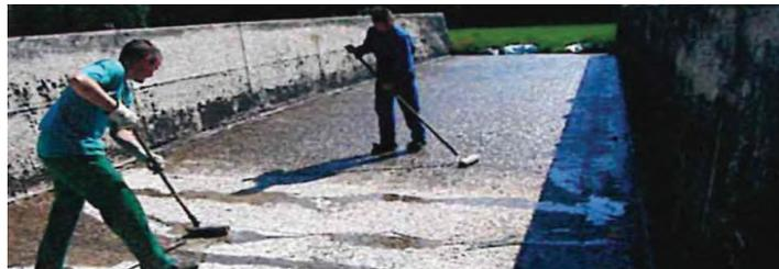
Avec un rouleau à poils longs (env. 18 mm), appliquer l'apprêt époxy AC 110 sur la surface sèche des plaques de béton et des parois de silo (consommation : min. 300 g/m<sup>2</sup> selon le support, temps de traitement : env. 20 minutes). L'apprêt AC 110 ne s'applique pas seulement à la surface d'un support, mais il y pénètre et s'y ancre. Généralement, la surface revêtue peut être recouverte par le vitrificateur de finition AC 130 après env. 24 heures (selon température et humidité de l'air).
