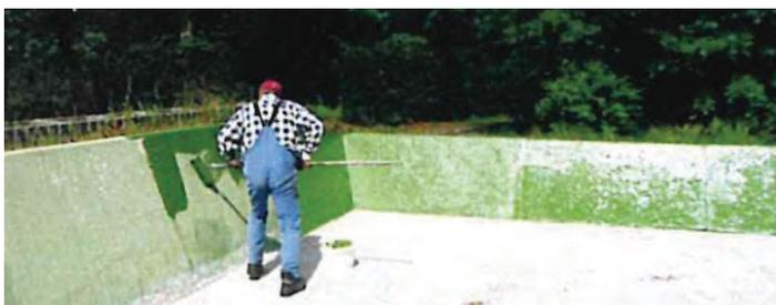
Avec un rouleau à poils longs (env. 18 mm), appliquer le revêtement époxy 2 en 1 AC 122 sur la paroi sèche du silo (consommation : min. 400 g/m<sup>2</sup> selon le support, temps de traitement : env. 20 minutes). Le revêtement AC 122 possède d'excellentes propriétés d'adhérence et d'infiltration, et se distingue par sa résistance élevée à l'abrasion et aux produits chimiques. Éviter les revêtements de sol.
